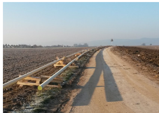
Abb.9 Neuverlegung einer Gashochdruckleitung
